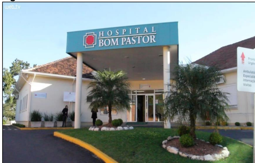
Figura 8 - Foto fachada HBP
