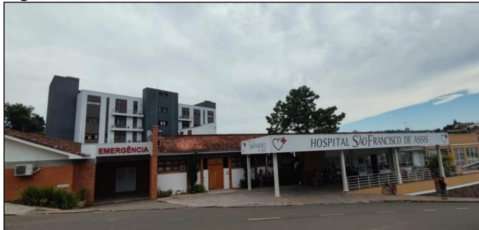
Figura 9 - Foto fachada HSFA
