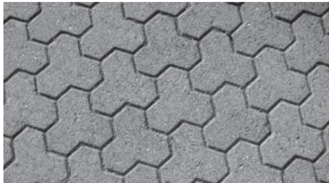
Figura 3 – Pavimentação observada em uma calçada
