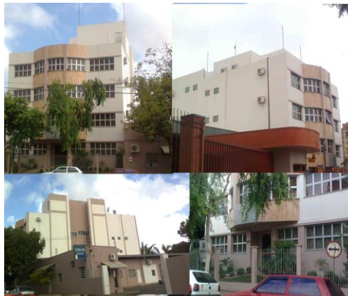
Figura 1: Fotografias do Prédio
