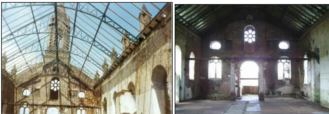
Figuras 21 e 22: Vista interna da Antiga Igreja Matriz – Intervenção no telhado.
