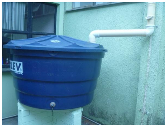
Figura 2: Captador para água da chuva nas dependências da Escola
