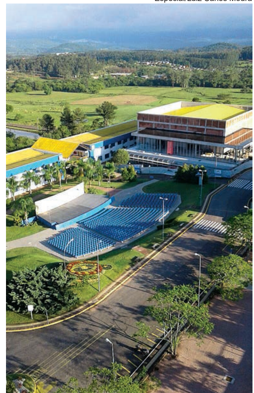
Prédio toma forma no interior do campus
