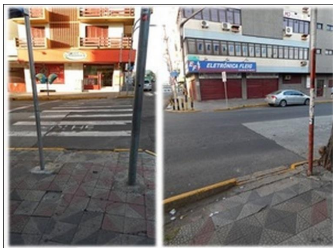
Figura 12: Rua Do Acampamento com Rua José Bonifácio, Centro, Santa Maria, RS.
